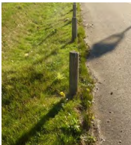
Dispositif de protection d'une noue à installer dès la phase chantier. Source : Area
