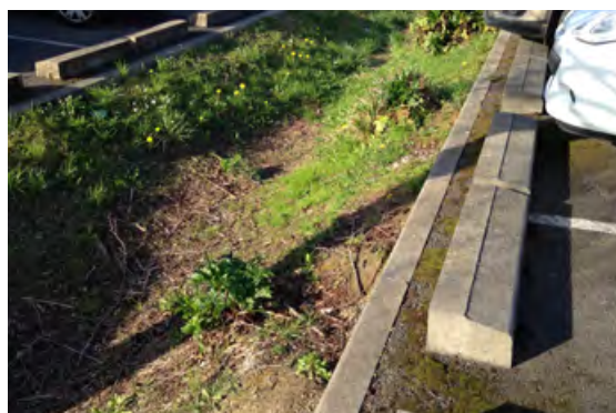
Exemple de bordure interrompue le long de la voirie ou des zones de stationnement et bordure arasée le long de la piste cyclable permettant aux écoulements de rejoindre l'espace vert. Nay (64). SEPIA Conseils
