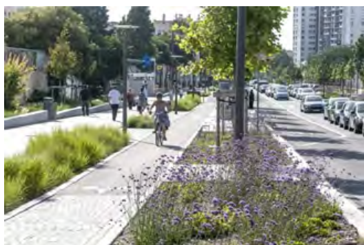
Bandes de séparation végétalisées aménagées le long de la rue Mermoz à Lyon dans le cadre de sa requalification.
